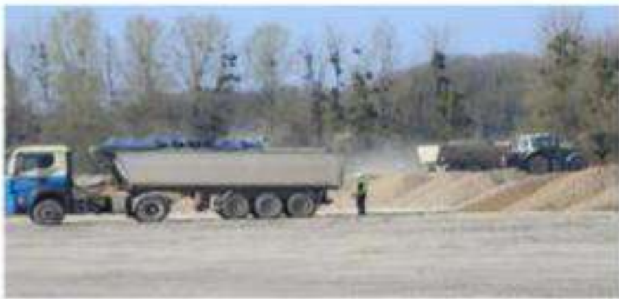
Les travaux de terrassement ont débuté en novembre 2024 et devraient s'achever d'ici le mois de mai. Photo Leo Vallée
