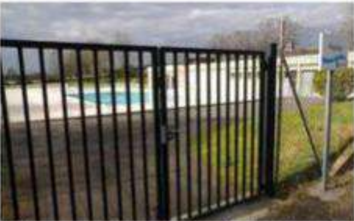
La CCBG assure que tout est mis en œuvre pour résoudre cette situation. (1) Impact
