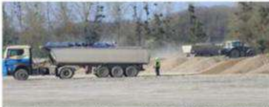
Les travaux de terrassement ont débuté en novembre et devraient s'achever d'ici mai. Photo : V. Lemaître
