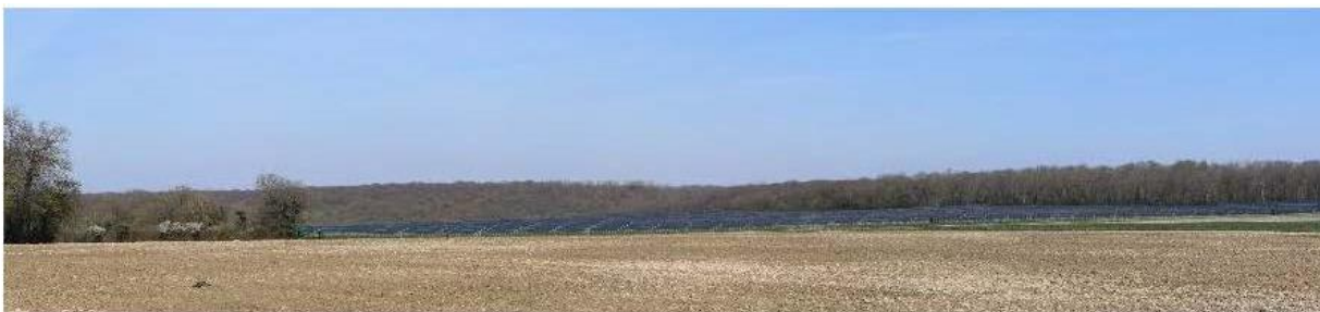
Photo prise en point bas de la D2 et écrasée (on voit moins le champ et à peine 1,5 panneaux alors qu'il y a 15 m de dénivellement sur le champ PV)
